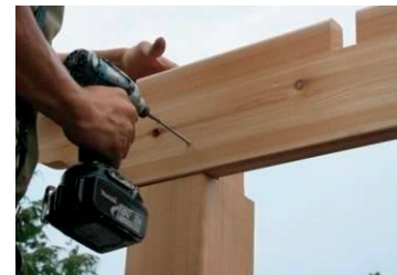
Using 2½" screws 4 per side
